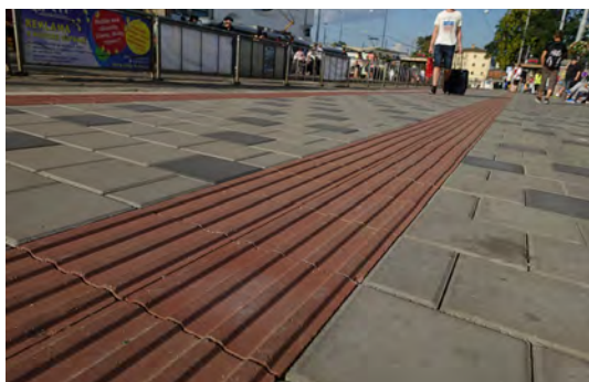
Obrázek č. 29 – Umělé vodicí linie
