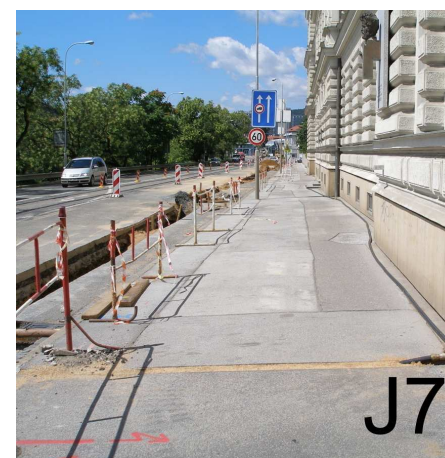
-bezbariérová úprava asf.chodníku ulice Poříčí -ve výstavbě
