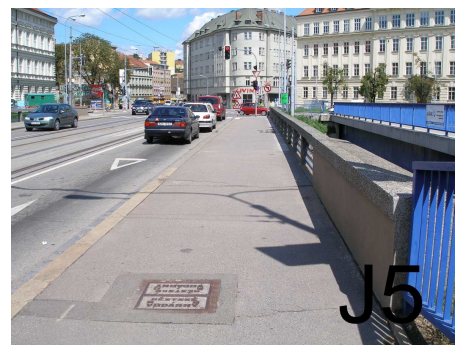
-bezbariérová úprava asf.chodníku ulice Vídeňská
