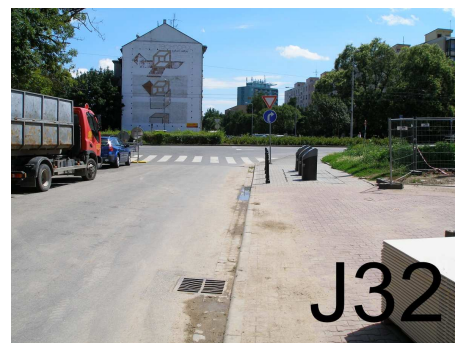
-bezbariérová úprava dl.chodníku ulice Křídlovická -ve výstavbě
