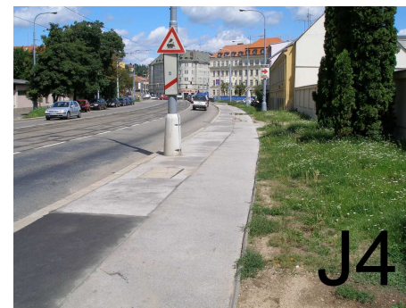
-bezbariérová úprava asf.chodníku ulice Vídeňská
