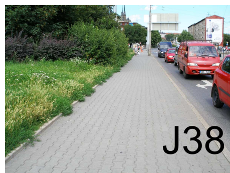
-bezbariérová úprava dl.chodníku ulice Nové sady
