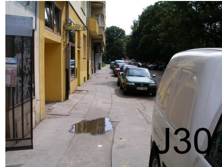
-bezbariérová úprava asf.chodníku ulice Leitnerova
