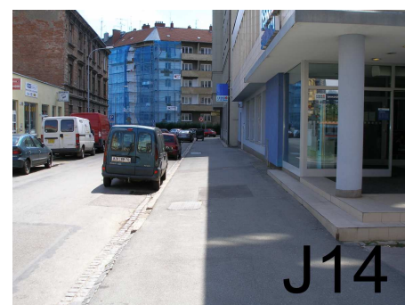
-bezbariérová úprava asf.chodníku ulice Křídlovická
