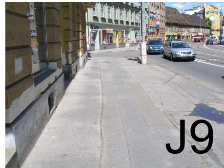
-bezbariérová úprava asf.chodníku ulice Křížová
