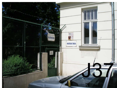
-bezbariérový přístup k objektu ozn. 017 /bariérový vstup /
