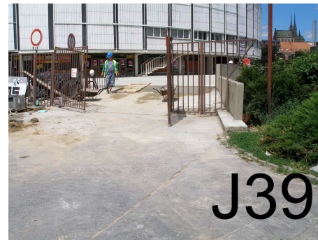
-bezbariérový přístup k objektu ozn. 105 /ve výstavbě /
