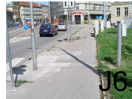
-bezbariérová úprava asf.chodníku ulice Křížová
