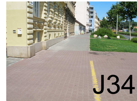
-bezbariérová úprava dl.chodníku ulice Nové sady
