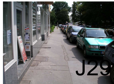
-bezbariérová úprava asf.chodníku ulice Leitnerova
