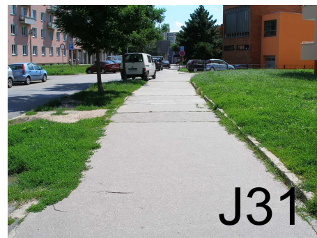
-bezbariérová úprava asf.chodníku ulice Křídlovická
