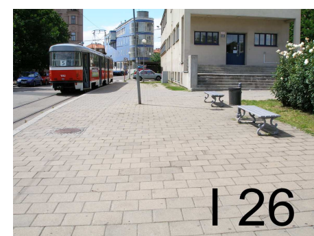
-bezbariérová úprava dl.chodníku ulice Nádražní
