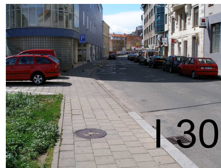
-bezbariérová úprava dl.chodníku ulice Kopečná
