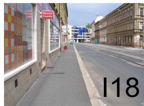
-bezbariérová úprava asf.chodníku ulice Hybešova
