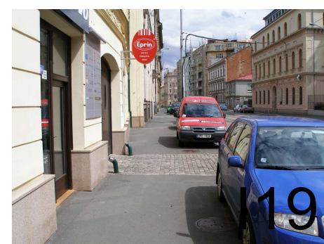
-bezbariérová úprava asf.chodníku ulice Hybešova
