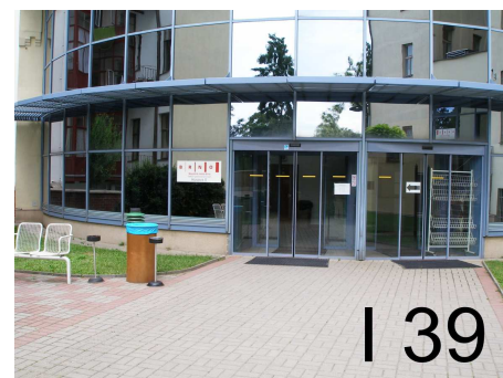
-bezbariérový vstup do objektu ozn.009
