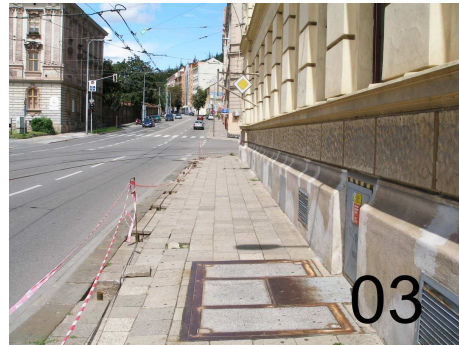
Stáv.dl.chodník s poškozeným povrchem, nutná rekonstrukce. Dl.140 bm-plocha 350 m 2 , Mendlovo náměstí.
