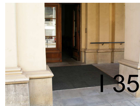
-bezbariérový vstup do objektu ozn.089 /WC,výtah /
