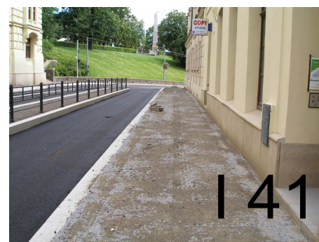
-bezbariérová úprava dl.chodníku ulice Husova
