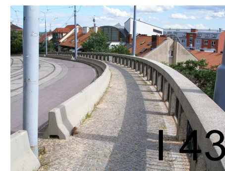
-bezbariérová úprava dl.chodníku ulice Husova
