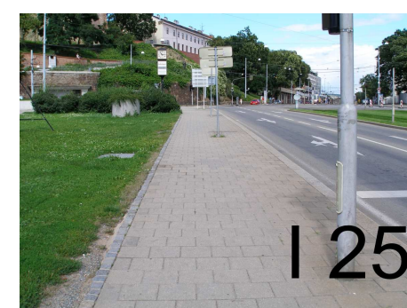
-bezbariérová úprava dl.chodníku ulice Nádražní
