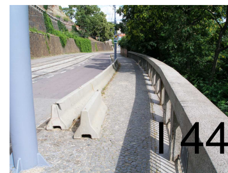
-bezbariérová úprava dl.chodníku ulice Husova
