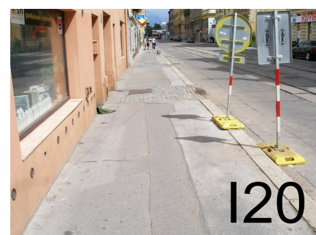
-bezbariérová úprava asf.chodníku ulice Hybešova
