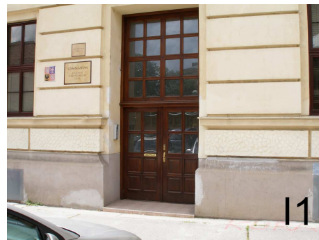
-bariérový vstup do objektu ozn.035
