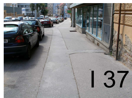
-bezbariérová úprava asf.chodníku ulice Pekařská
