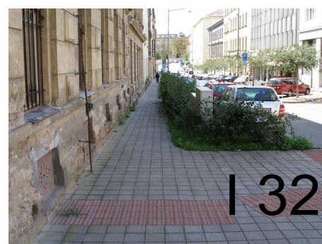
-bezbariérová úprava dl.chodníku ulice Anenská
