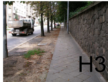
-bezbariérová úprava stáv.dl.chodníku ulice Úvoz/oprava povrchu/
