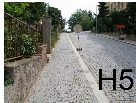
-bariérová úprava ulice Gorazdova- spád nad 12,5%
