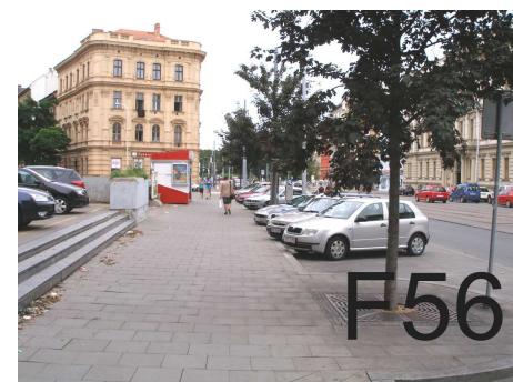
-bezbariérová úprava dl.chodníku ulice Lidická
