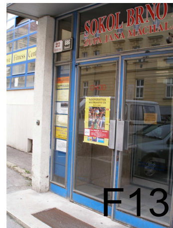
-bariérový vstup do objektu ozn.058
