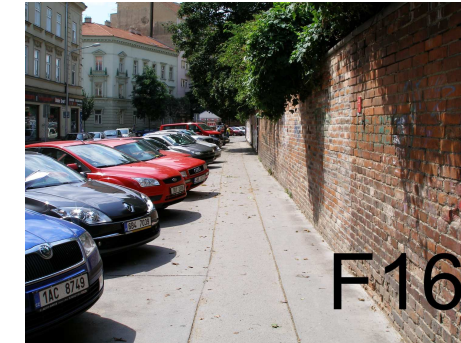
-bezbariérová úprava asf.chodníku ulice Pekárenská
