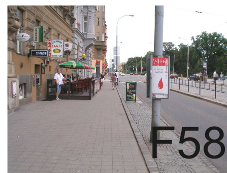
-bezbariérová úprava dl.chodníku ulice Lidická
