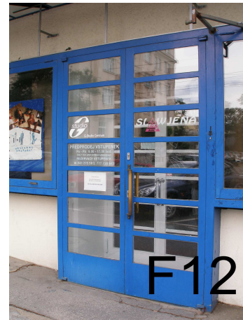
-bariérový vstup do objektu ozn.134
