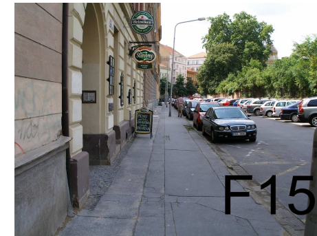
-bezbariérová úprava asf.chodníku ulice Pekárenská
