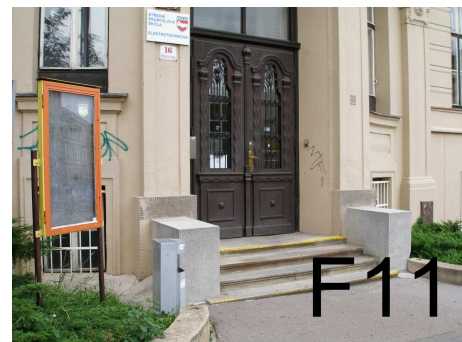
-bariérový vstup do objektu ozn.133
