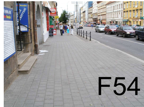
-bezbariérová úprava dl.chodníku ulice Lidická
