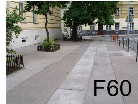
-bezbariérová úprava asf.chodníku ulice Botanická
