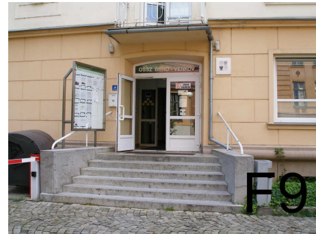
-hlavní bariérový vstup do objektu ozn.132 /boční vchod bezbar.,výtah,WC/
