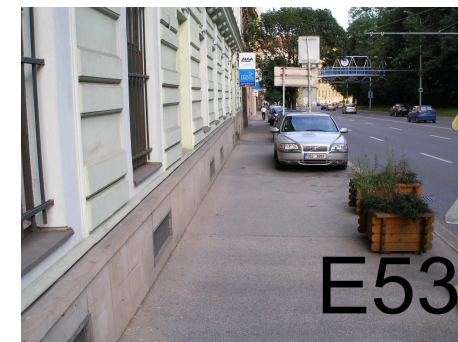
-bezbariérová úprava asf.chodníku ul.Koliště
