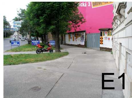
-bezbariérová úprava asf.chodníku ul.Koliště
