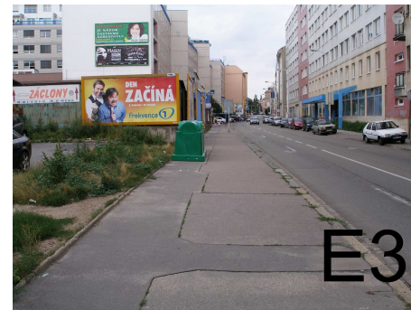
-bezbariérová úprava asf.chodníku ul.Příkop
