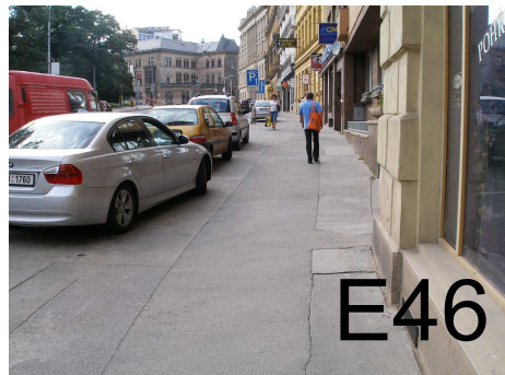
-bezbariérová úprava asf.chodníku ul.Koliště
