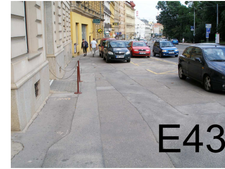
-bezbariérová úprava asf.chodníku ul.Koliště
