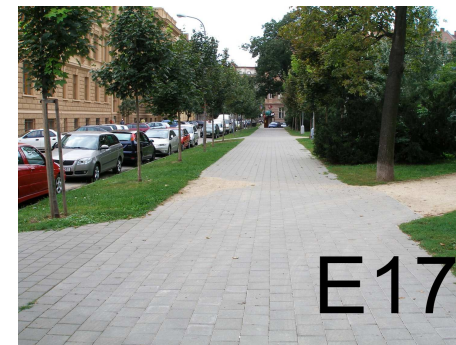
-bezbariérová úprava dl.chodníku ul.Kudelova
