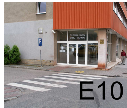
-bezbariérový vstup do obj.ozn.117 /výtah/
