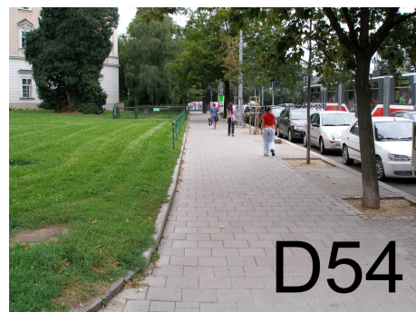
-bezbariérová úprava dl.chodníku - ul.Rooseveltova
