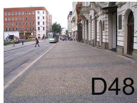
-bezbariérová úprava dl.chodníku - ul.Rooseveltova
