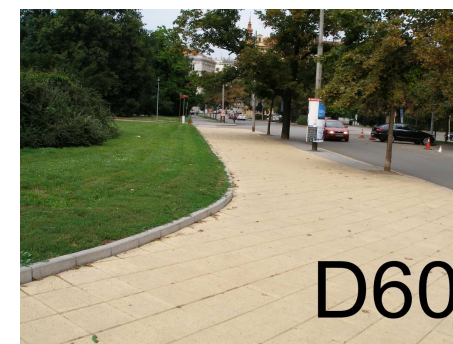
-bezbariérová úprava dl.chodníku - ul.Jezuitská
