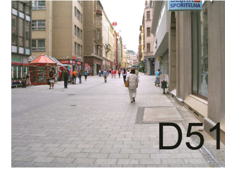
-bezbariérová úprava asf.chodníku - ul.Koblížná -pěší zóna
