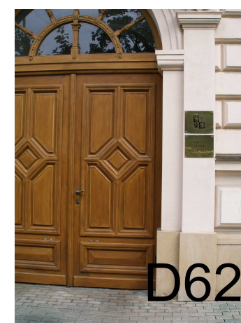
-bezbariérový vstup do obj.ozn.108 /před výtahem 2 schody-bar.přístup,WC v patře,výtah/
