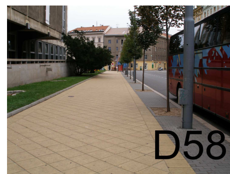
-bezbariérová úprava dl.chodníku - ul.Rooseveltova
