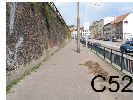
-bezbar.úprava chodníku ulice Koliště-druhá strana
