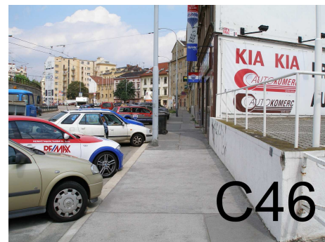
-bezbar.úprava chodníku ulice Koliště
